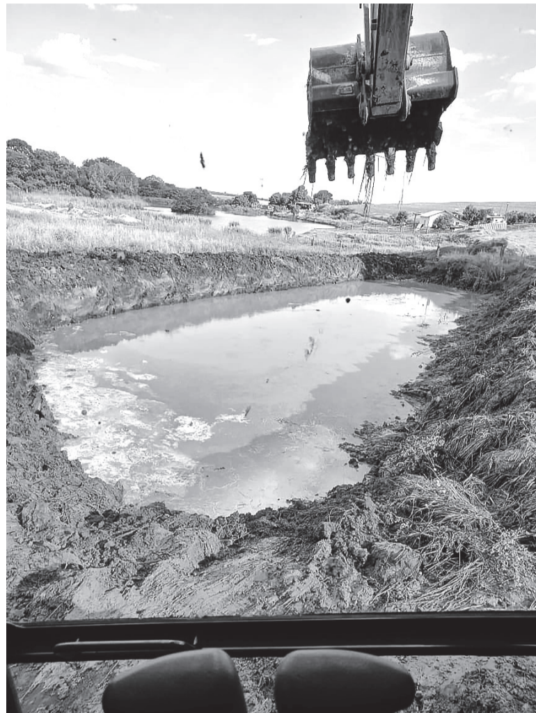
Até dia 26 foram atendidas 12 propriedades com construção de açudes emergenciais e abertura de valas
